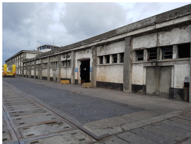
Figura 3 – Porto de Ponta Delgada - Açores. Requalificação das Infraestruturas Portuárias. Armazéns a demolir no âmbito do Projecto de reabilitação das Infraestruturas. Foto 16 Out 2017.
